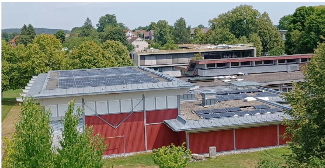
Ausbau Photovoltaikanlage auf der Kleinsporthalle in Bad Schussenried
