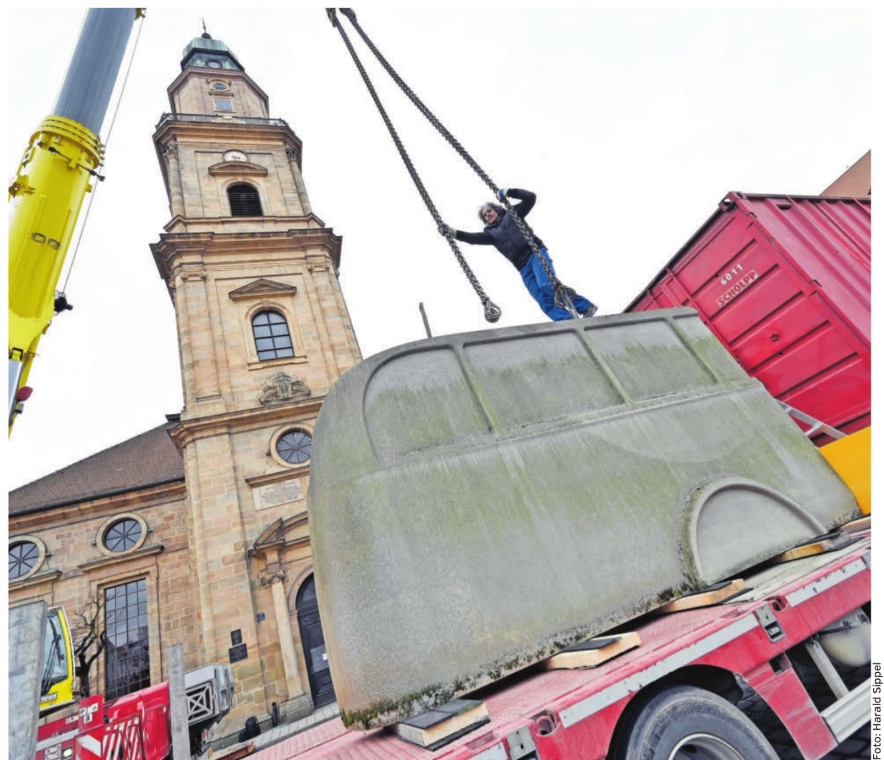
Vor der Hugenottenkirche fahren Tieflader mit Betonteilen vor, die von einem Autokran heruntergehoben wurden.
