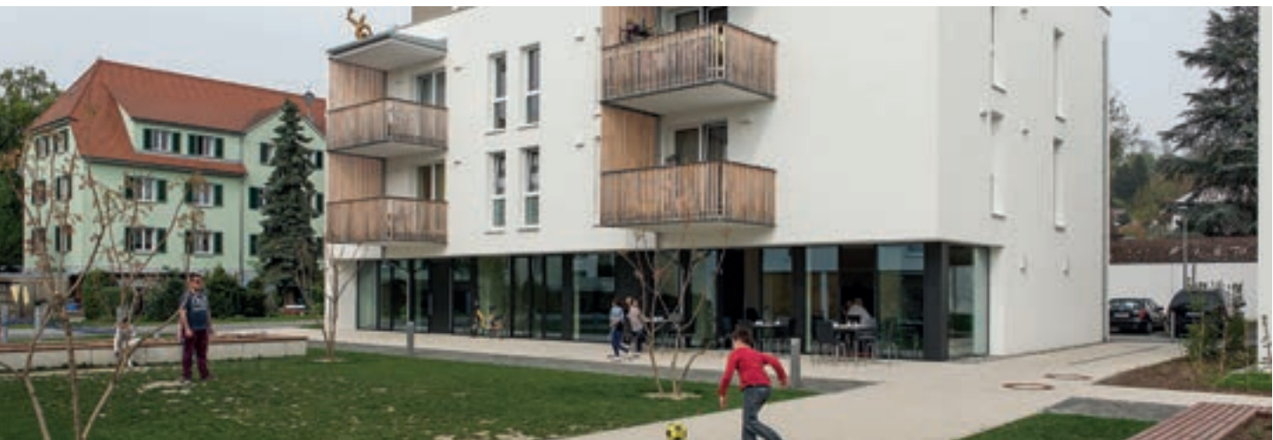
Im unteren verglasten Teil des Mehrfamilienhauses befinden sich der Waschsalon und der Gemeinschaftsraum.
